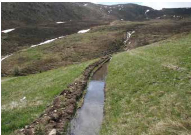
Abbildung 13: Händisch gegrabener AlmWaal nach erfolgter Instandhaltung (© Wolfgang Ressi)
