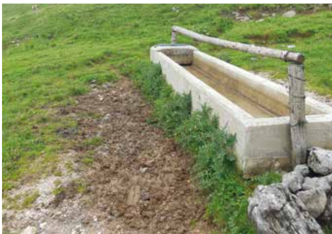
Abbildung 11: Tränketrog aus Beton (© Stefan Hellebart)
