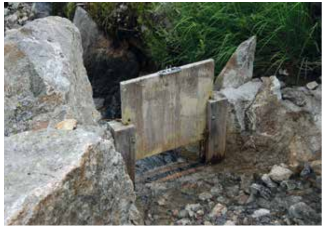
Abbildung 14: Bewässerungswasser fließt vom Zuleitungsgraben in die Rieselrinnen. Mit einem Brett kann die Zuleitung abgesperrt werden. (© Stefan Hellebart)
