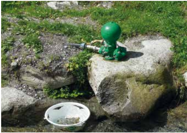
Abbildung 9: Ein „Hydraulischer Widder“ ist eine Pumpe, die den Druckstoß nützt, um einen Teil des Wassers, mit dem die Pumpe angetrieben wird, auf ein höheres Geländeniveau zu heben. (© Stefan Hellebart)
