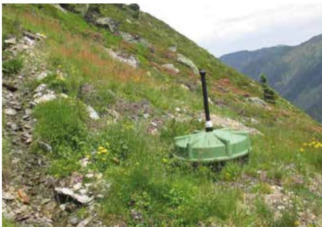
Abbildung 27: Ungeeignete Quellfassung (© Josef Mallaun)
