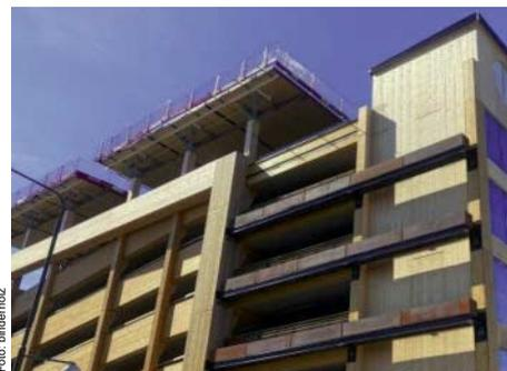
3.850 m<sup>3</sup> Brettsperrholz und 1.000 m<sup>3</sup> Brettschichtholz werden insgesamt im neuen Parkhaus verbaut.
