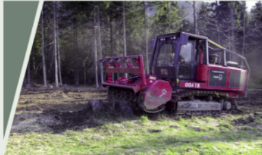
Wurzelstockrodungen: Bagger mit Roderechen und Forstmulcher
