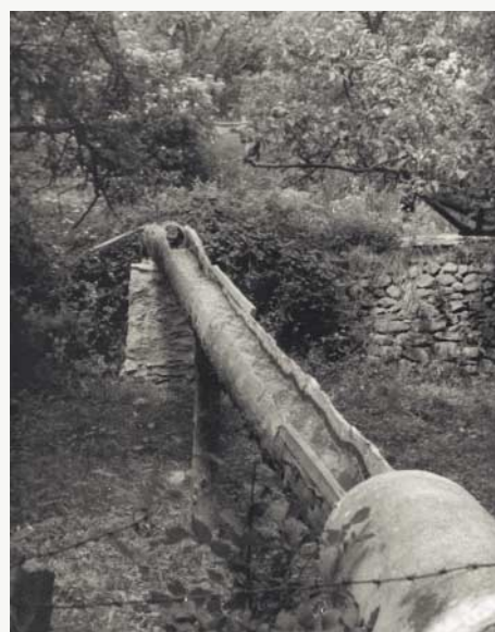
Glurns. Wasserleitung über den Stadtgraben beim Malser Tor, 1951.
