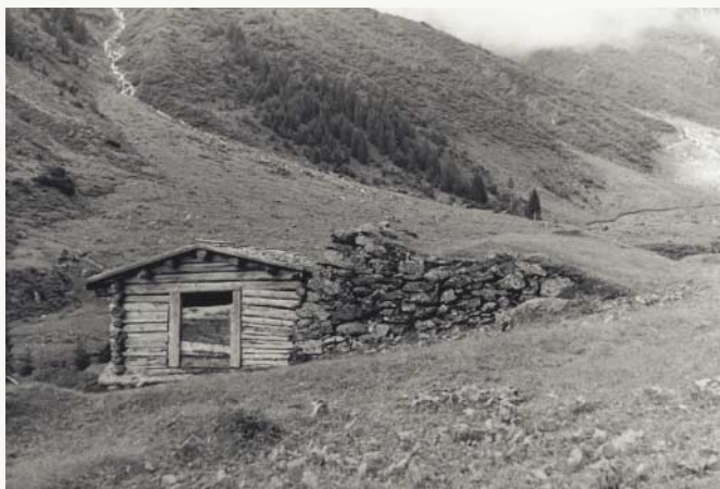
Lapones-Alm. Heustadel mit „Wurfmauer“ als Lawinenschutz, 20. August 1941
