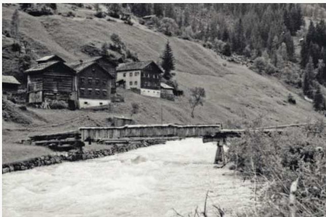
Holzbrücke über der Trisanna im Paznaun, 1937.
