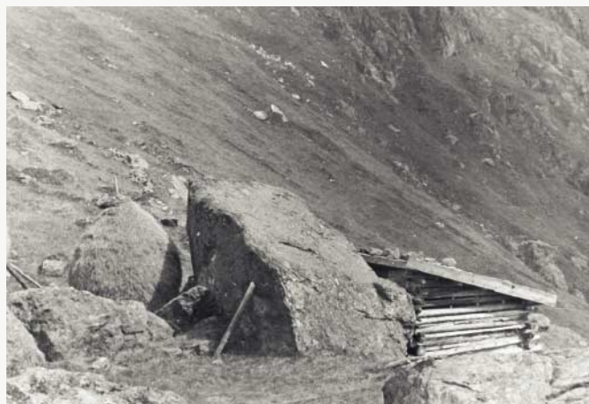
Bergheustadel in den Stubaier Alpen mit Pultdach und „Wurfmauer“ als doppelten Lawinenschutz, 1943
