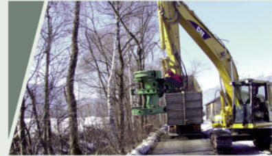
Baum- und Strauchrodungen mit Bagger und Zwickler: Materialübernahme möglich
