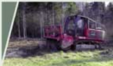
Wurzelstockrodungen: Bagger mit Roderechen und Forstmulcher
