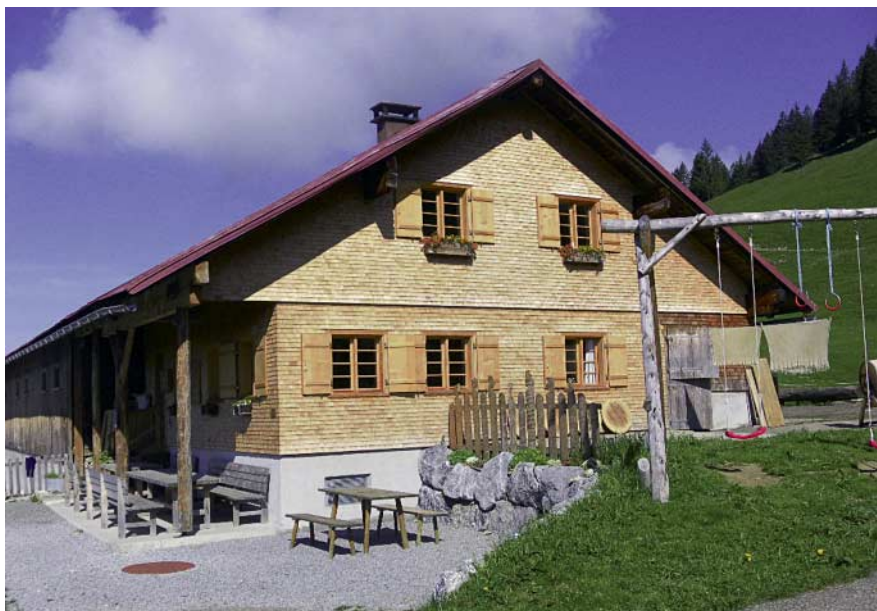
Das Alpegebäude mit neuer Fassade.
