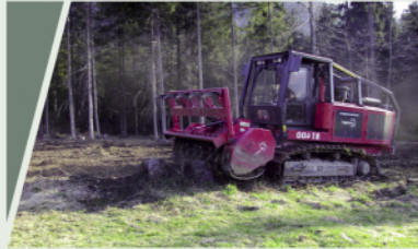
Wurzelstockrodungen: Bagger mit Roderechen und Forstmulcher
