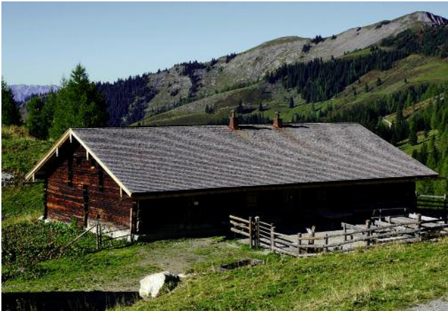
In ländlichen Gebieten war das Holzschindeldach einst weit verbreitet (l.). Mit dem Reifmesser werden die Schindeln auf der „Hoanzlbank“ geputzt und gespranzt (r.).
