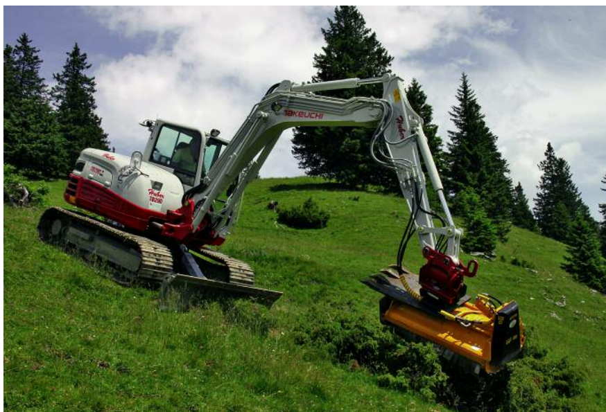
Bild 4: Der Einsatz schwerer Maschinen sollte kleinflächig und wohlüberlegt erfolgen.
