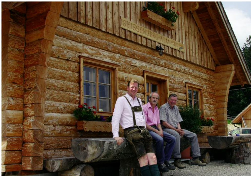
Die neue, mit Mondholz errichtete, Almhütte.
