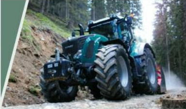
Steinzerkleinerung: Wege-, Straßen- und Flächensanierung
