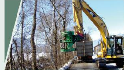
Baum- und Strauchrodungen mit Bagger und Zwicker: Materialübernahme möglich
