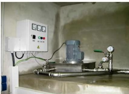
Trinkwasserkraftwerk 3 KW 230 V
