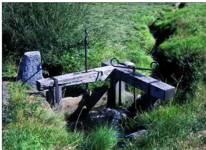
Wasserteilung durch Schleusen
