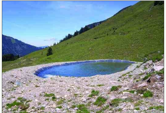
Der neu errichtete Speicherteich
