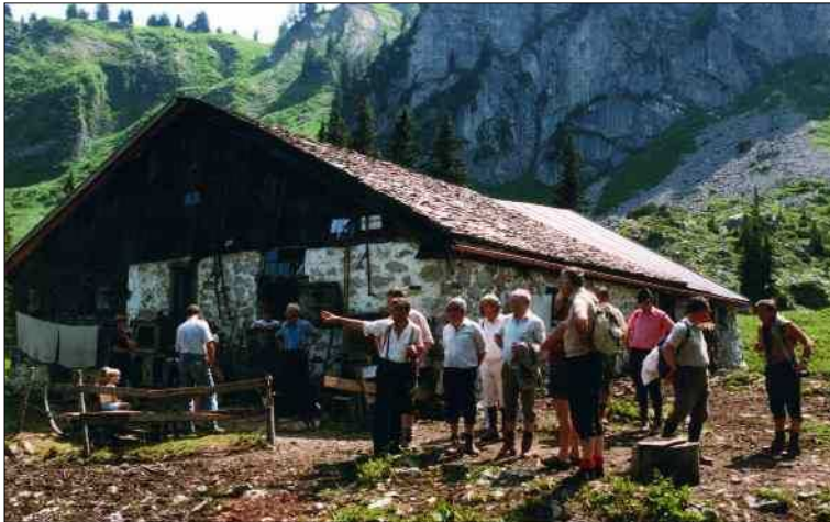
Im Jahr 2000 wurde die Alphütte im Gesertobel generalsaniert
