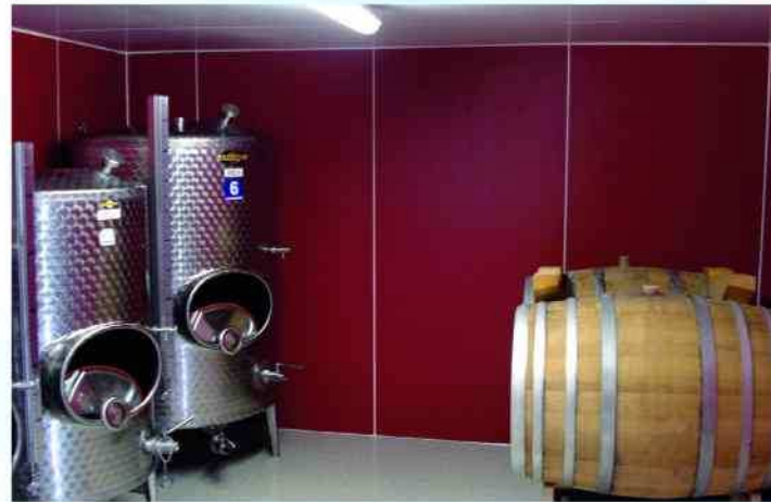
Gelungener Umbau mit ISO THERM
