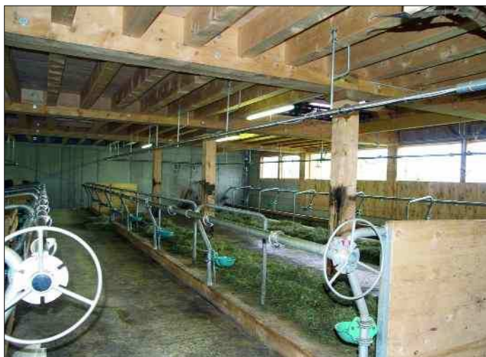
Auf der Alpe Untere Falz wurde ein neuer Alpstall für rd. 100 Milchkühe errichtet
