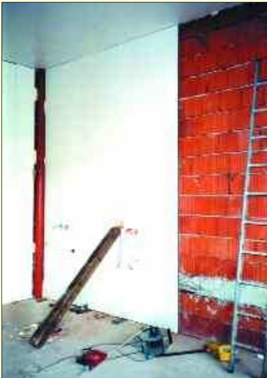
Bild: 4 cm PASTNERIT vom Ab-Hof-Landwirt selbst verlegt, Decke, Wand und Trennwände. Die Milchammer im Sommer kühl - im Winter frostfrei und rein.
