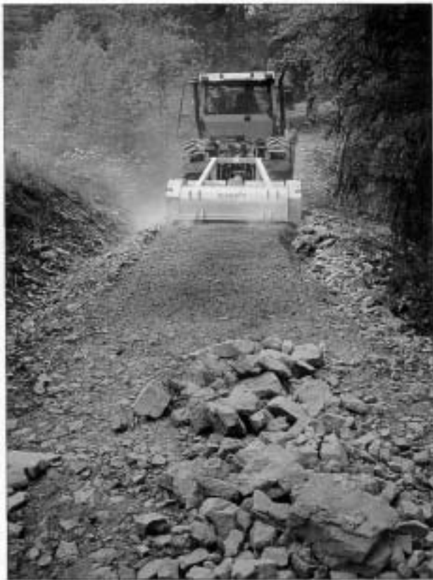
Der Steinbrecher bricht das grobsteinige Material zu feinem Wegbaukies
