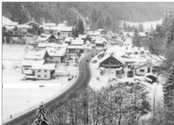
Die Besiedelung ist in das damalige Katastrophengebiet vorgezogen
