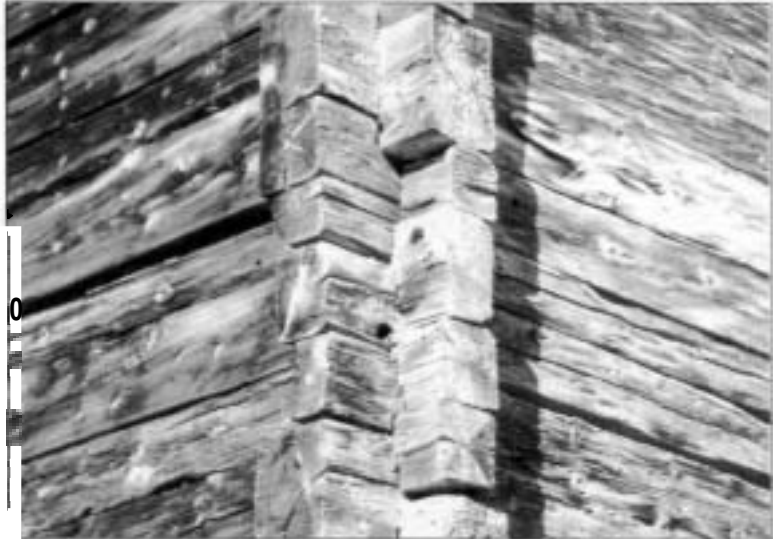
Ein Blockhaus mit - entsprechend der Sonneneinstrahlung - verschieden gefärbten Wänden. Links die Süd-, rechts die Ostseite
