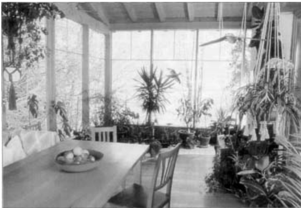
Wintergarten aus unverleimten, massiven Fichtenbalken
