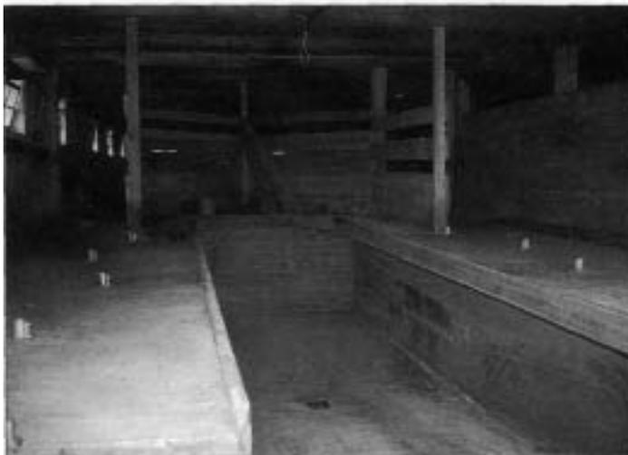
*Die Grube für den schnellen Ein- und Ausbau des Melkstandes*
